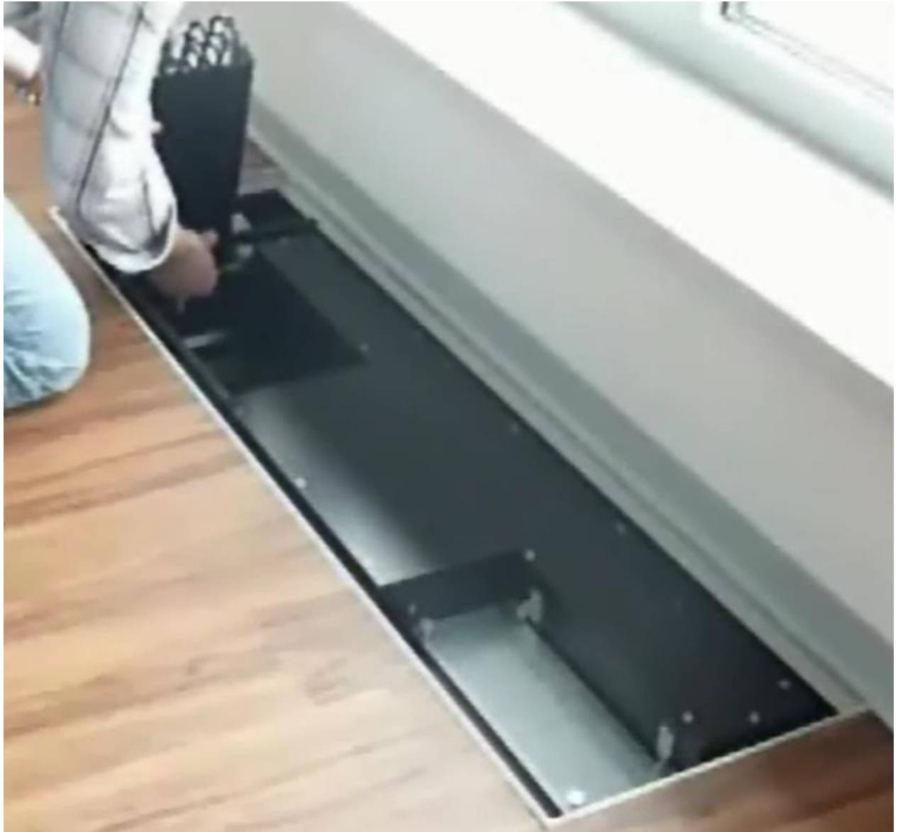
Abb. 11 Wärmetauscher in Wartungsposition fixiert
