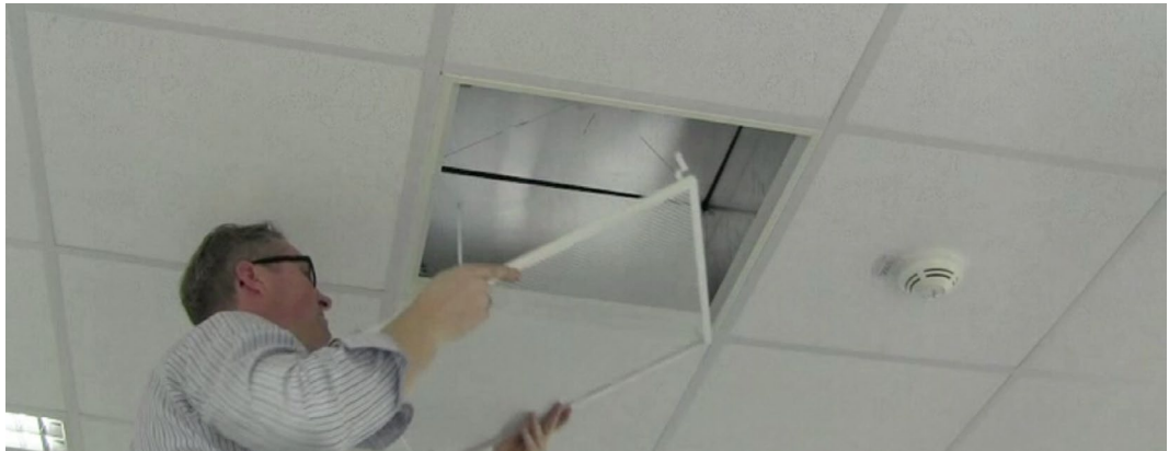
Abb. 9. Frontblech aus der Verankerung nehmen.
