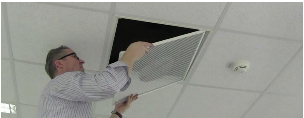
Abb. 14. Frontblech mit Prallplatte montieren
