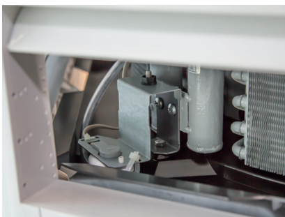
Schwimmerschalter am Halteblech montiert
