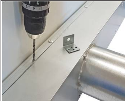
Abb. 5: Löcher bohren
