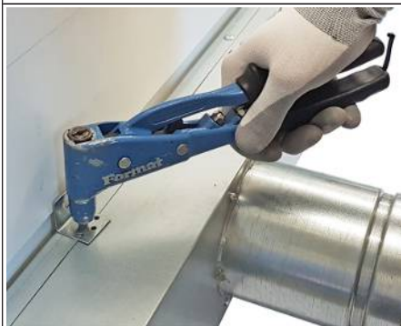
Abb. 6: Winkel mit Gehäuse verbinden
