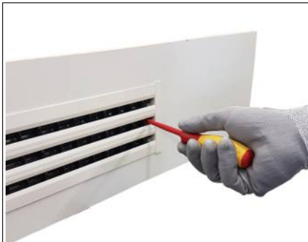
Abb. 11: Schrauben links und rechts lösen.
