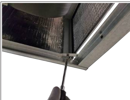
Abb. 54: Filterriegel drehen
