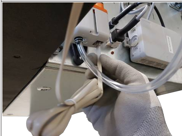
Abb. 29: Signalkabel Schwimmerschalter einstecken
