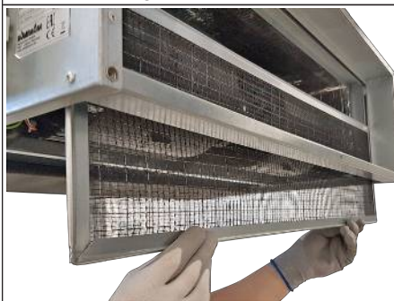
Abb. 55: Filter herausziehen
