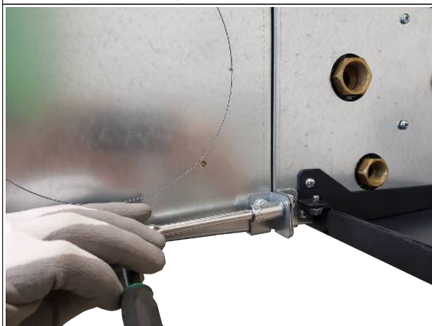
Abb. 11: Schrauben außen anziehen
