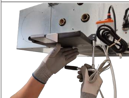
Abb. 61: Kondensatwanne lösen und halten
