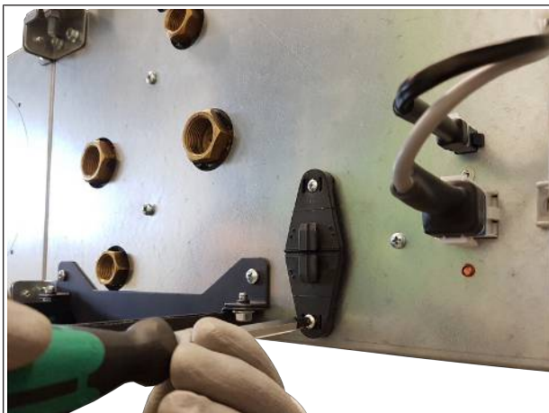
Abb. 21: Halter für Pumpe anbauen
