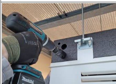
Abb. 16: Anschlusslöcher öffnen
