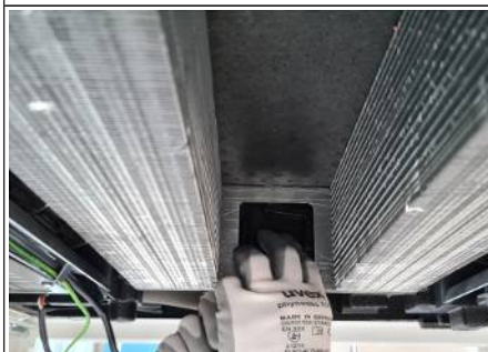
Abb. 25: Primärluftabdeckung entfernen
