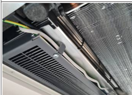
Abb. 19: Kabel Stellantrieb verlegen
