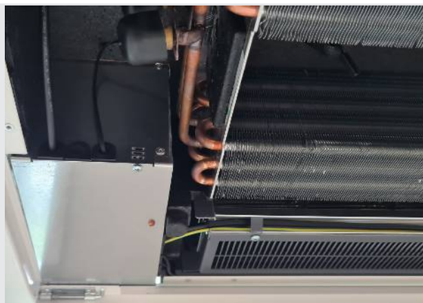
Position Elektroanschlussbox (bei abgenommener Kondensatwanne)
