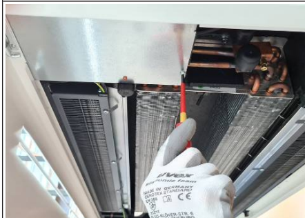
Abb. 20: Elektroanschlusskasten öffnen
