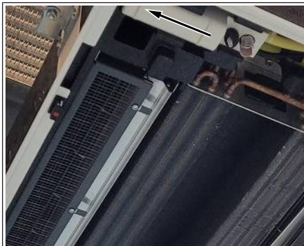
Abb. 22: Korrekter Sitz der Kondensatpumpe
