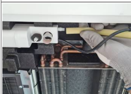
Abb. 21: Kondensatschlauch an Kondensatpumpe befestigen
