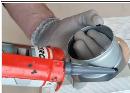
Abb. 24: Primärluftanschlussstutzen abdichten
