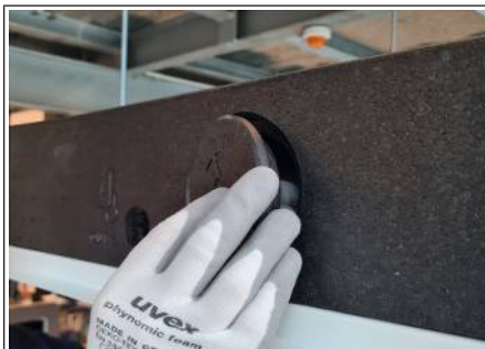
Abb. 23: Primärluftstutzen abnehmen
