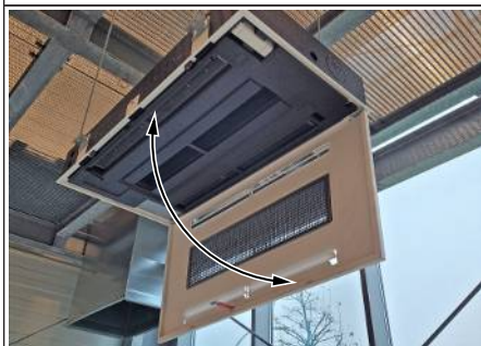
Abb. 9: Designblende geöffnet
