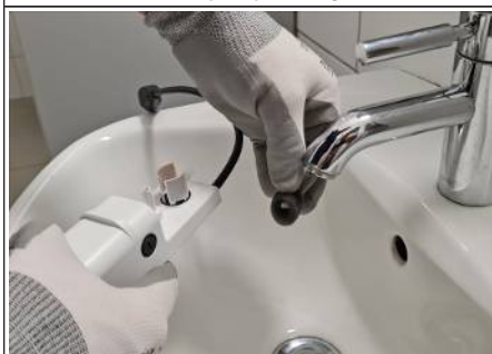
Abb. 46: Schmutzfilter reinigen
